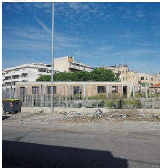
La struttura da completare nel quartiere di Sbarre
